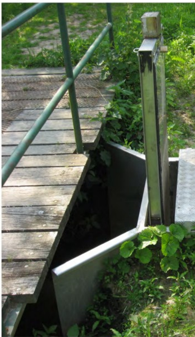
Vanne en aval
