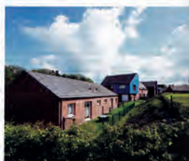
Sur le site Flament, la rénovation de l'ancienne tannerie a permis la construction de 21 logements au total (ILM, la résidence du Bocage).
