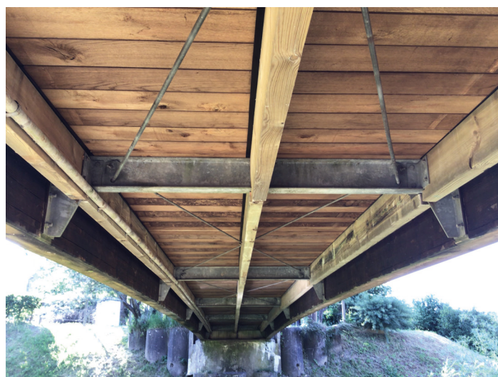
Passerelle du Parc Despret Remplacement de tous les bois
