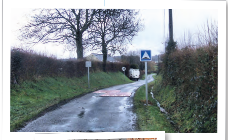
La sécurité encore et toujours ! Pose de coussins-berlinois Rue des Anorelles - Février 2021
