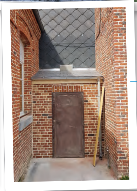
Ancienne école du Point du Jour Aménagement de l'ex-chaufferie Avril 2021
