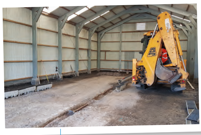
Le bâtiment communal économique Zone Saint-Laurent Réalisation d'une dalle complète - Mai 2021
