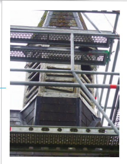
La Chapelle Saint-Gorgon Le clocher a souffert avec le temps et la foudre Rénovation complète par l'entreprise Folatre Avril à juin 2021
