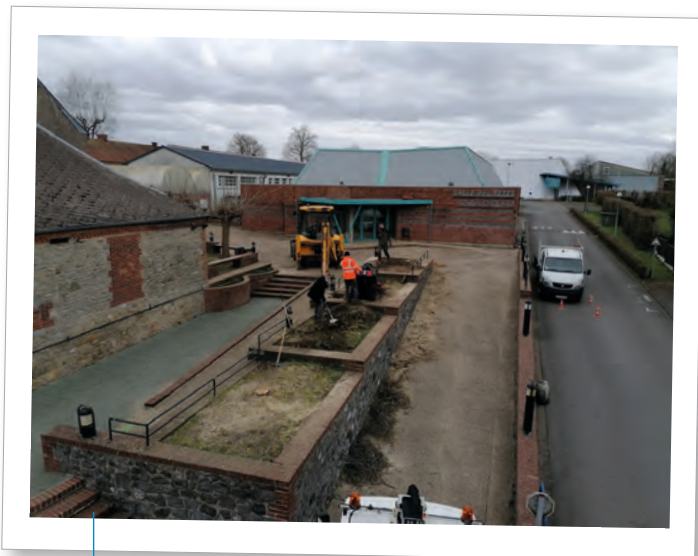
Accès Salle des Fêtes - Ecole du Petit Verger Réfection totale des bacs à fleurs et replantation adaptée - Février 2021
