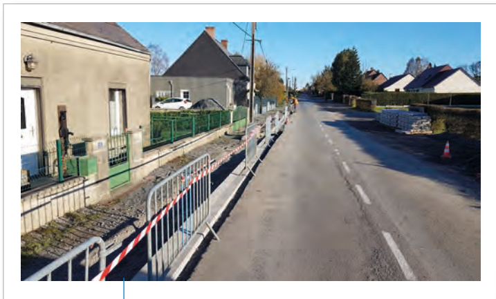
Rue du Revin Pose d'un fil d'eau - Novembre 2020
