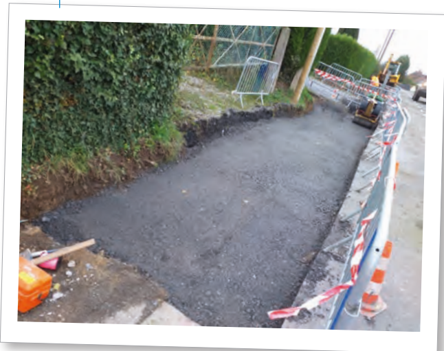
Rue du Revin Pose de bordures et réalisation d'un trottoir début des travaux - Novembre 2020
