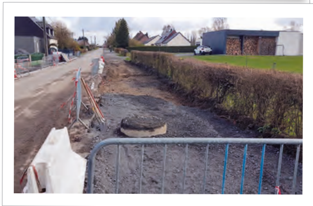
Rue du Revin Préparation du trottoir et du stationnement Novembre 2020
