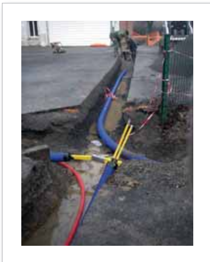
• Point du Jour Travaux d'enfouissement des réseaux de chaleur alimentés par la chaudière bois-énergie – février 2017
