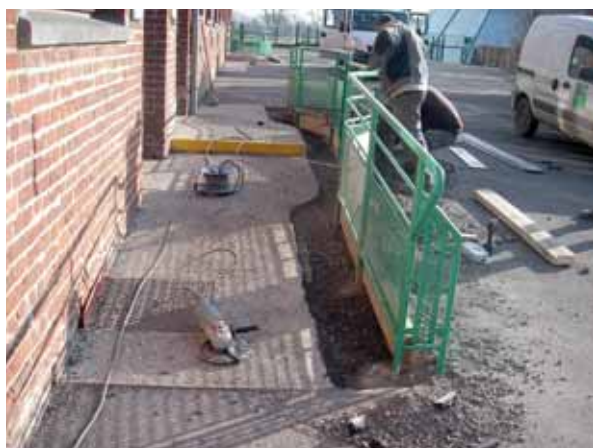
• Ecole du Centre « Le Petit Verger » Mise en conformité accessibilité – janvier 2017
