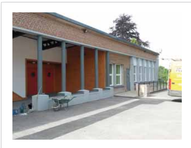
• Point du Jour Travaux de peinture extérieure – juin 2017
