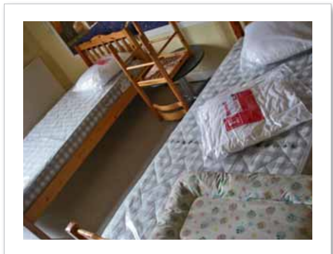
• Maison de la Solidarité Rénovation et équipement mobilier – février 2017
