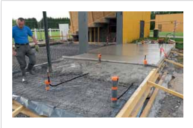
• Stade - Création du Club-house Coulage de la dalle – mai 2017
