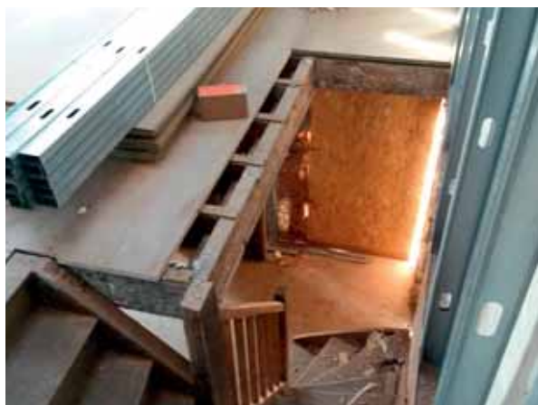
• Quartier de la Galoperie Réhabilitation d'une maison communale En cours de travaux – avril 2017
