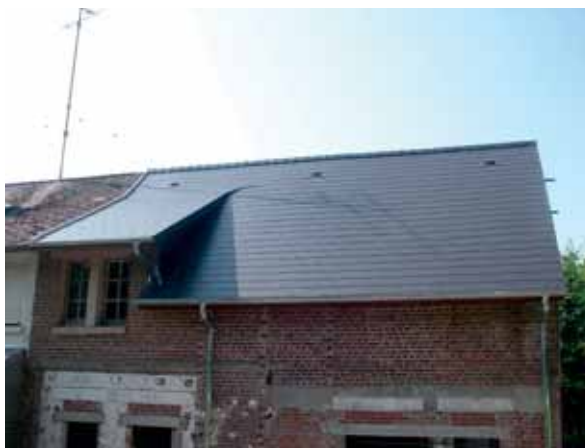
• Quartier de la Galoperie Réhabilitation d'une maison communale Changement de la toiture – juin 2017
