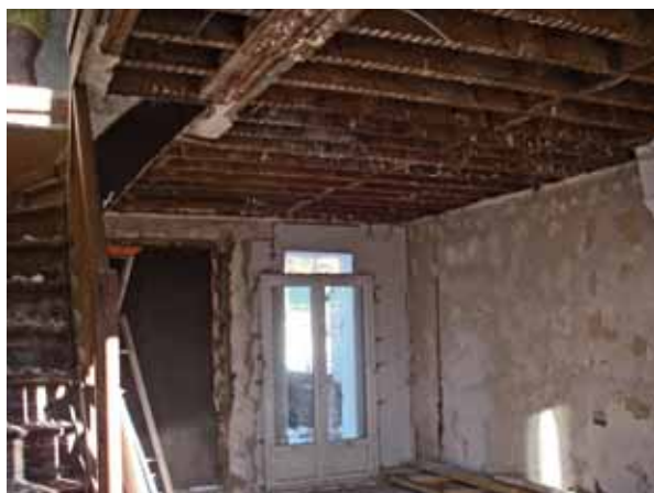
• Quartier de la Galoperie Réhabilitation d'une maison communale Avant travaux - janvier 2017
