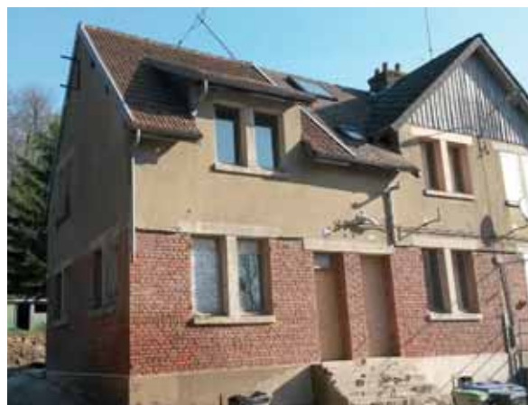
• Quartier de la Galoperie Réhabilitation d'une maison communale Travaux extérieurs de piquetage – mars 2017
