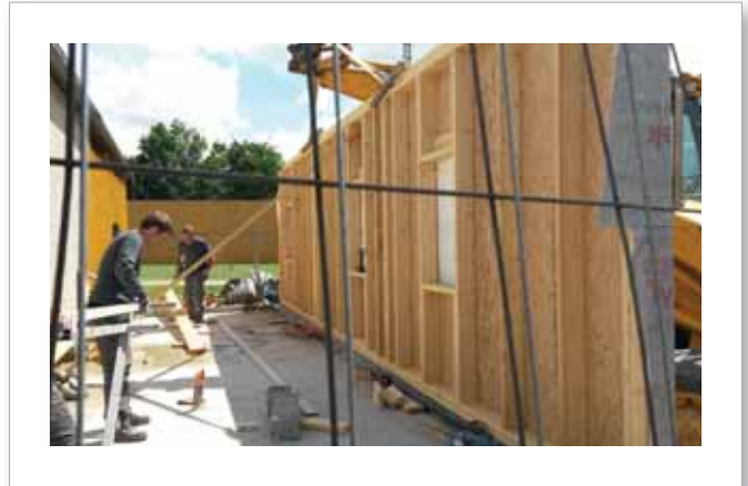
• Stade - Création du Club-house Création de l'extension sanitaires accessibilité – juin 2017
